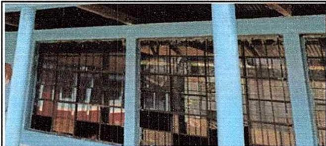
Foto 4: Los balcones de las aulas del módulo 1estan oxidados se necesita una pintada.
