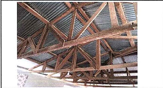
Foto 3: Las costaneras del módulo 1 estan deterioradas
