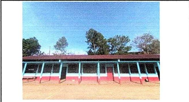
Foto1: El techo del módulo 1 esta deteriorado y con goteras
