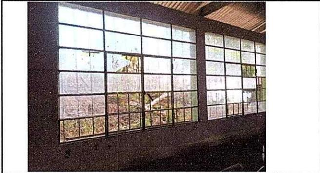
Foto 4: Los vidrios de las ventanas del módulo 1 estan quebradas
